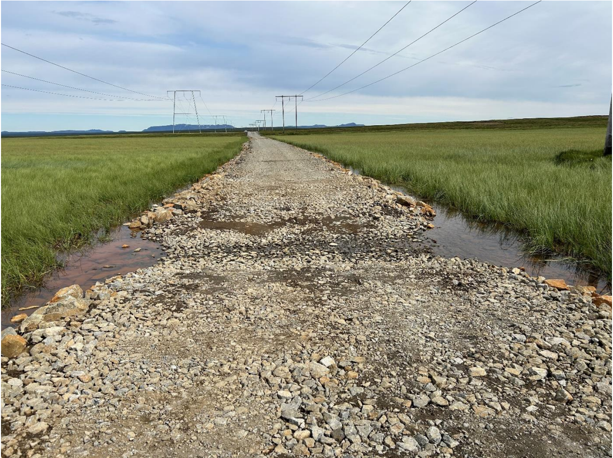
Mynd 7.9 Slóðagerð yfir votlendi við Hólasandslínu 3.
