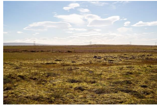
Mynd 10.59 Horft til austurs í átt að núverandi byggðalínu á Holtavörðuheidi.
