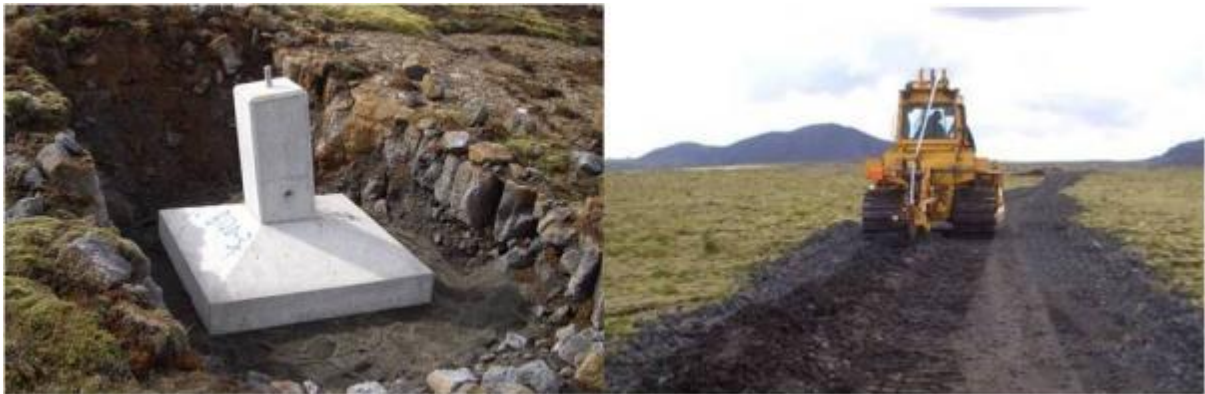
Mynd 7.5 Til vinstri má sjá forsteypta undirstöðu masturs og til hægri sést hvernig jarðskaut er plægt í kant á vegslóð.
