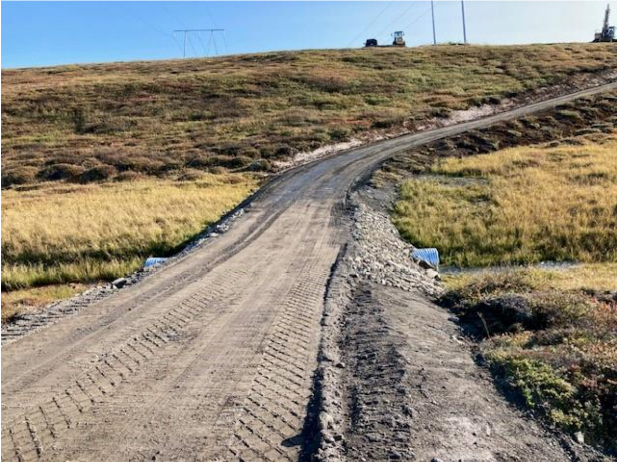
Mynd 7.10 Vinna við slóðagerð og frágang við Hólasandslínu 3.
