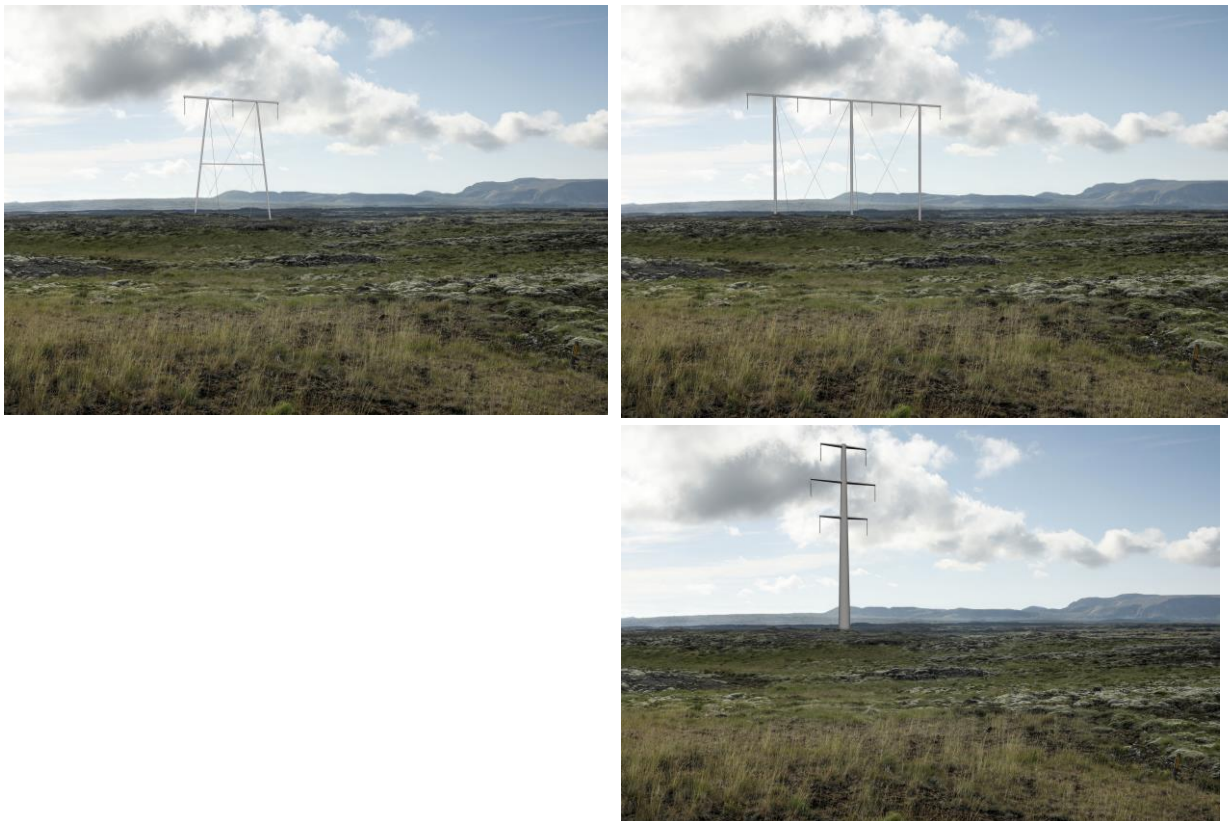
Mynd 7.4 Myndir sýna dæmi um 132 kV mastur (efri mynd til vinstri) til samanburðar við tvírása 220 kV mastur með lárétta uppröðun (efri mynd til hægri) og tvírása 220 kV mastur með lóðrétta uppröðun (neðri mynd til hægri).
