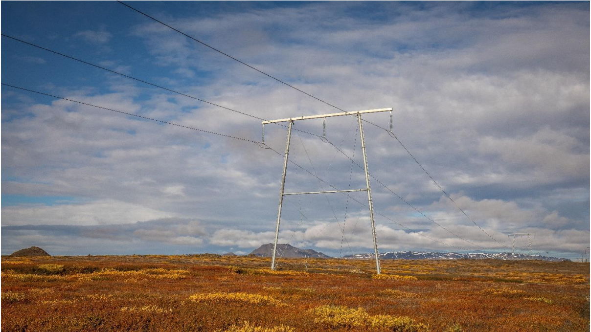
Mynd 7.2 Mastursgerð sem stefnt er að því að nota á stærstum hluta Holtavörðuheidiarlínu 1. Mynd sýnir mastur án jarðvíra.
